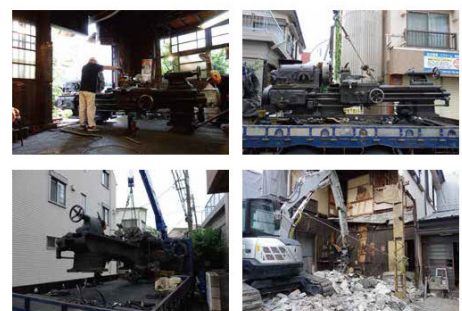
図2参考 解体撤去される機械と町工場
