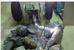
押し出し機でワーム型ロボットを進展させる様子
